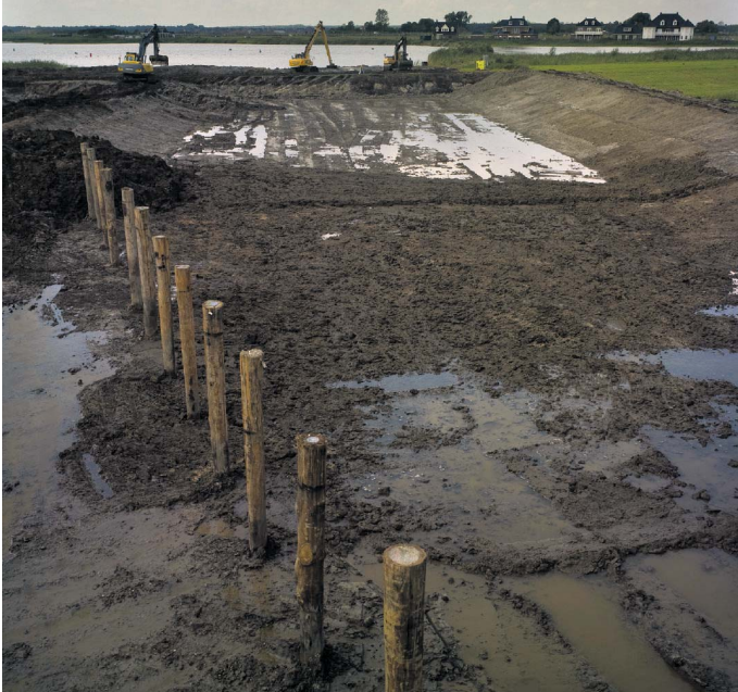
Vorbereidingen voor nieuwbouw bij de Blauwesat in Oostgroningen Foto's Sake Elzinga
